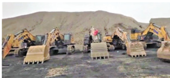
灭火工程将以剥挖及平整形式进行
